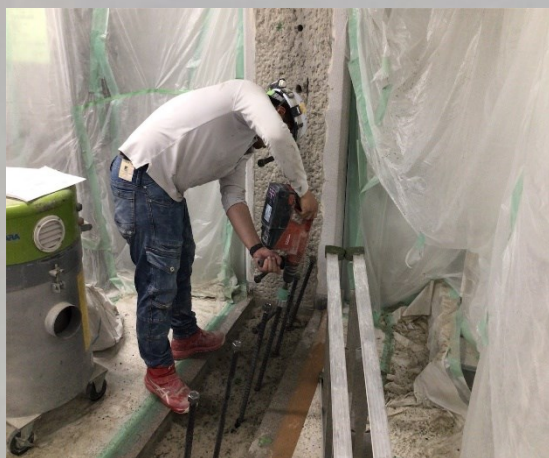
アンカー打設
