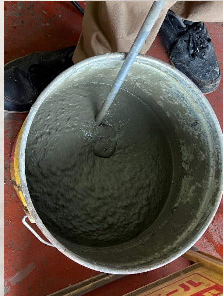
現場で所定の水を加えて グラウトミキサー又はハントミキサーで 練り混ぜ
