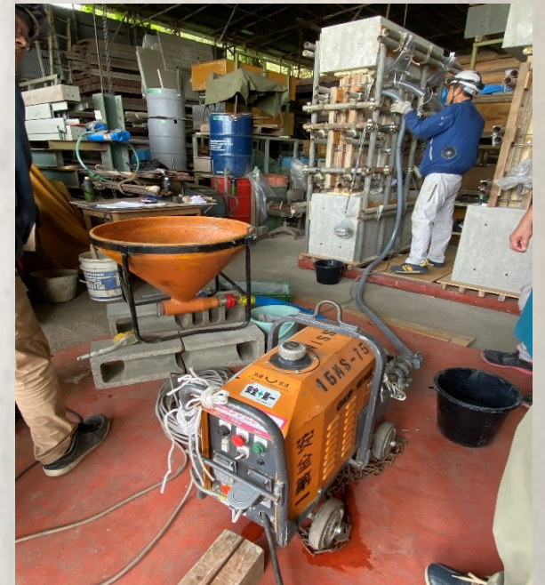
モルタルポンプで充填・圧入
